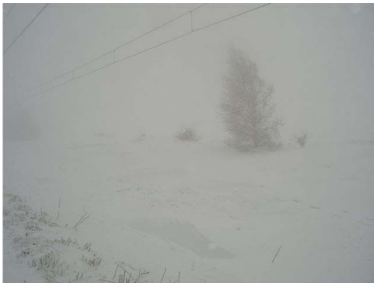
Abbildung 4 Wechtenbildung im Bereich der Entgleisungsstelle - Quelle ÖBB
