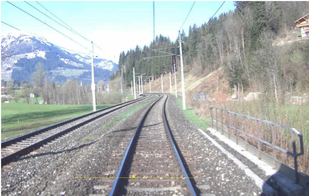
Abbildung 13 Aufnahme des Gleises im Bereich des Durchlasses vor der Entgleisung
