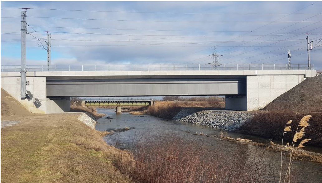
Abbildung: Eisenbahnbrücke über die Schwechat (Foto: Kühnert, 14.02.2019)
