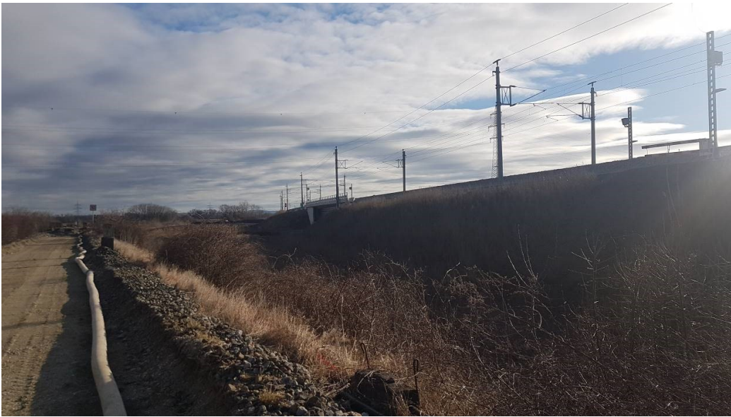
Abbildung: Dammlage im Bereich zwischen Heidbach- und Schwechatbrücke von Osten (Foto: Kühnert, 14.02.2019)
