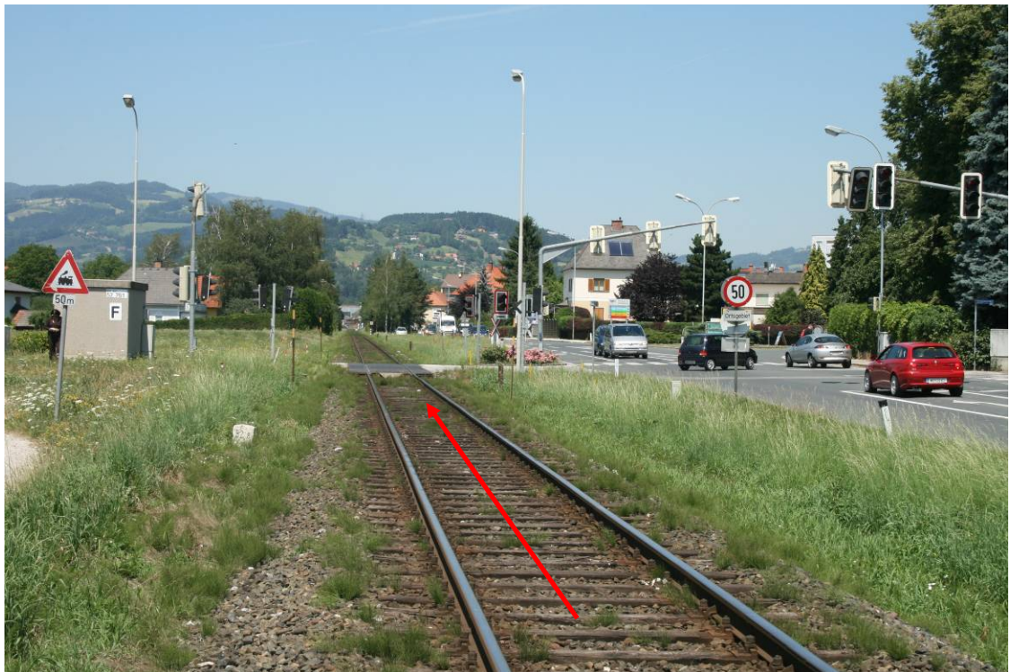
Abbildung 2 EK km 52,761 Blick in Fahrtrichtung Z 4530
