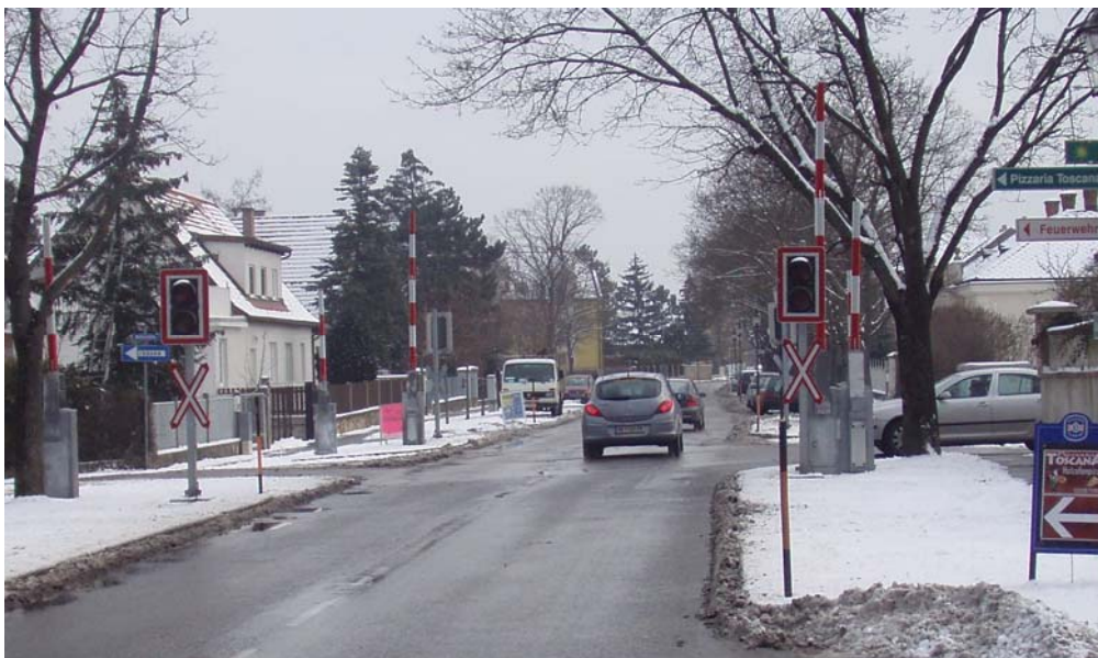
Abbildung 7 Ansicht Wiener Neustädter Straße in Richtung Wiener Neustadt
