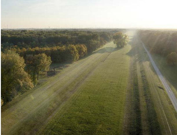
Sanierter Marchfeldschutzdamm, Bild: viadonau
