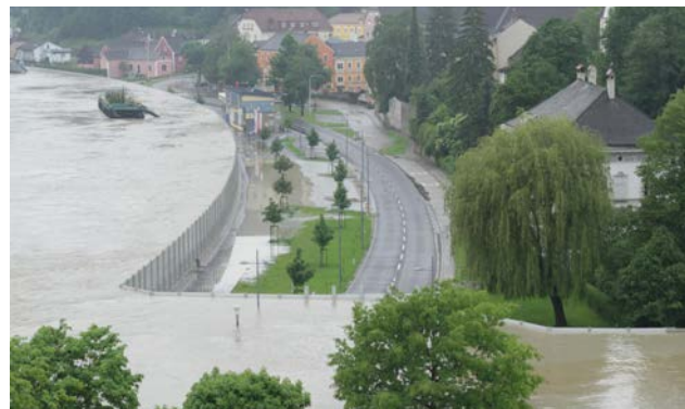
Mobiler Hochwasserschutz Grein, Bild: Robert Zinterhof
